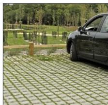
Pavé bétons avec joints engazonnés
