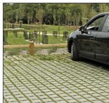
Pavé bétons avec joints engazonnés
