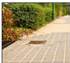
Pavé bétons avec joints sablés
