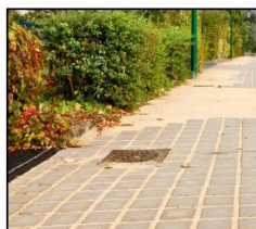
Pavé bétons avec joints sablés
